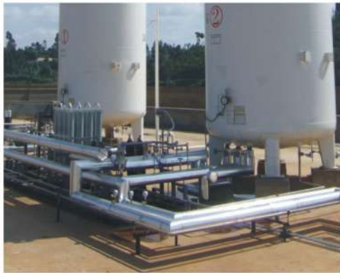
●保温管道安装
