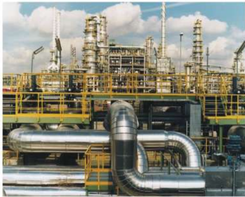
●管道安装集成
