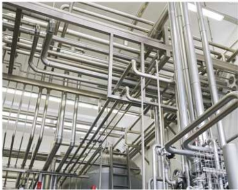
●工业管道安装
